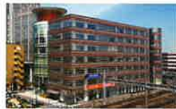
医疗保健学院大楼
